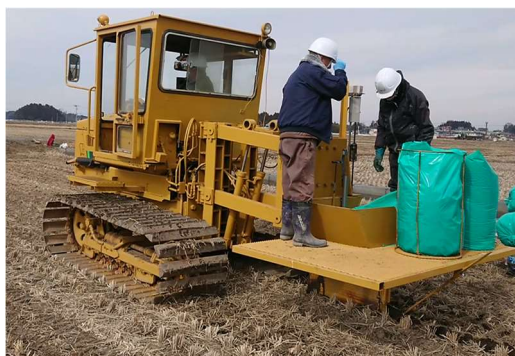
図1 ドレーン・リフレッシュ工法による施工状況
