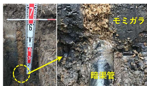
図5 新工法による暗渠再生状況
